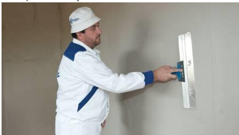
Obr. 3.: Aplikace sádrové omítky a stěrky v jednom materiálu pod názvem Rimano Glet XL. Finální srovnání povrchu bez broušení pomocí nerezové špachtle.
