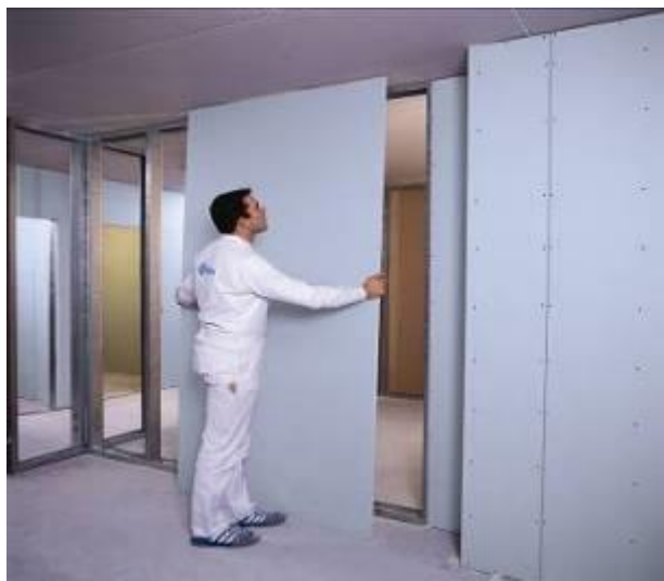
Obr.7: Akustické interiérové příčky s modrou sádrokartonovou deskou Rigips jsou jen 7,5 cm silné, a přitom o 3 dB překračují požadované normové požadavky na akustiku v bytě. V porovnání s jiným stavebním materiálem lze docílit při menší hmotnosti i tloušťce konstrukce novou stěnu za nižší pořizovací náklady a ještě rychleji.
