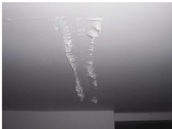
Obr. 2: Delaminace papíru ze sádrokartonové desky působením
