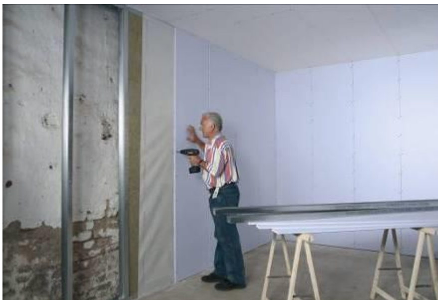
Obr.4: Montáž sádkartonové předstěny z modrých akustických desek Rigips. Umožní rychle vytvořit nový interiér. Předsazené stěny zaberou jen 6,5 cm při jednoduchém a 8 cm při dvojitém opláštění modrými akustickými deskami Rigips. Přidají 9 -12 dB (decibelů) akustické pohody. Problém s hlukem ze sousedního pokoje je vyřešen.
